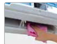
เช็ดทำความสะอาดภายในของช่องลมเย็น สอดมือเข้าด้านในได้สะดวก
